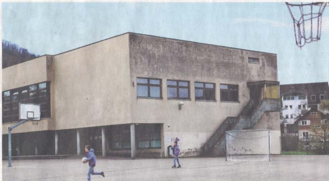
Die Bützenen-Mehrzweckhalle wird 2019 saniert, und die Treppe wandert gemäss Plan von der West- an die Südwand.
